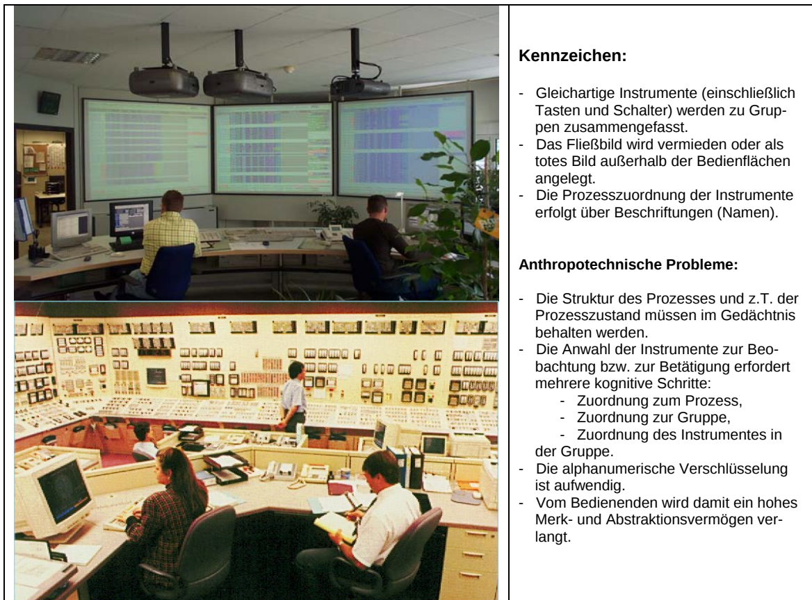
Bild 4.13: Beispiele für Blockstruktur aus einer Pkw-Montage und einem Kraftwerk.
